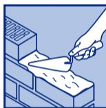
Нанесение и распределение приготовленной растворной смеси производится при помощи мастерка или кельмы. Для получения плотного и прочного соединения кирпичей друг с другом необходимо сплошное нанесение растворной смеси на все шовные поверхности. Требуемая толщина шва 3-6 мм.
