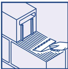
Полученную растворную смесь нанести тонким слоем на очищенные поверхности блоков. Рекомендуемая толщина шва между блоками после их укладки не должна превышать 2-5 мм. Блок следует уложить в течение 5-10 минут после нанесения растворной смеси на основание. Для экономичного расходования кладочной смеси рекомендуется использовать зубчатый шпатель.
