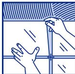
Плитки следует уложить в течение 20-25 минут после покрытия основания раствором. Время коррекции приклеенной плитки 5 минут. По свежее облицованному полу нельзя ходить в течение 48 часов.
